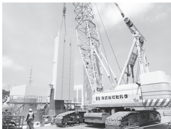
写真－2 鋼管杭工（上杭建込み）
