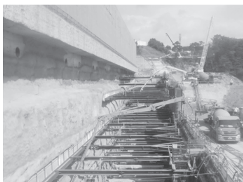
写真－4 置換コンクリート打設
