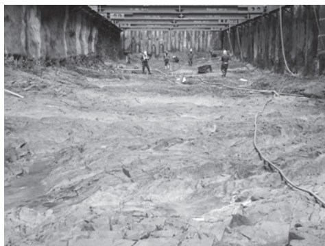
写真－3 置換コンクリート部掘削状況
