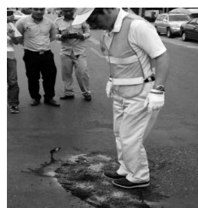
足踏みによる初期転圧
