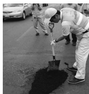
スコップによる施工状況
