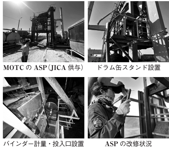
写真－4 MOTC の ASP 改修
