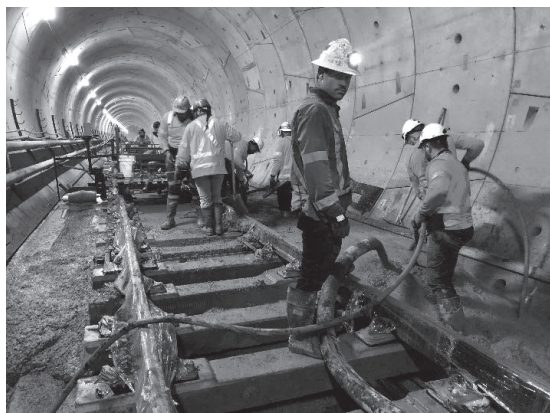
写真－5 Sydney Metro Northwest 軌道工事
