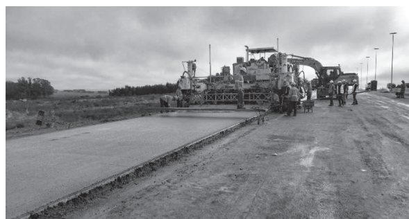
写真－6 パラグアイのコンクリート舗装工事
