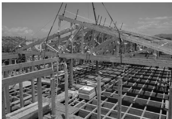
写真－4 BP材を使用した学校建設
