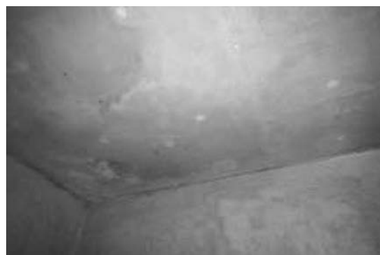
写真－9 エポキシ樹脂モルタルで補修した橋脚フーチング
