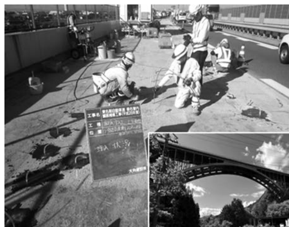
写真－1 高速道路橋の床版補修
