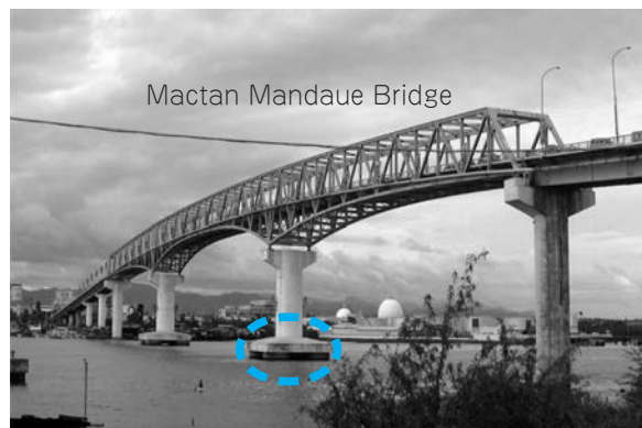
写真－7 マクタン・マンダウエ橋（青枠が補修箇所）
