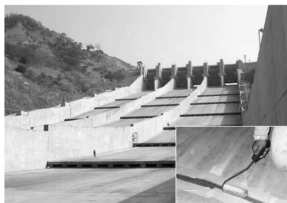
写真－10 サンロケダムのひび割れ補修
