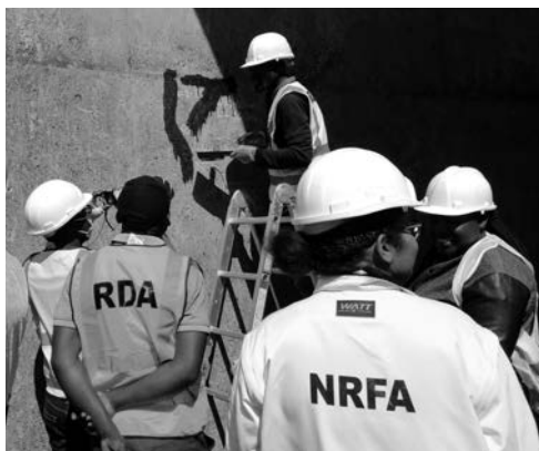
写真－13 アルファテック 380 を用いたひび割れ補修 OJT
