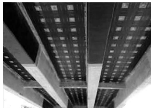
写真－12 炭素繊維補強
