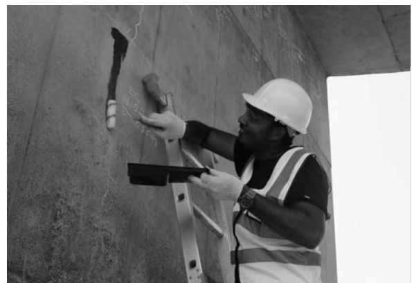
写真－5 アルファテック 380 の塗布状況
