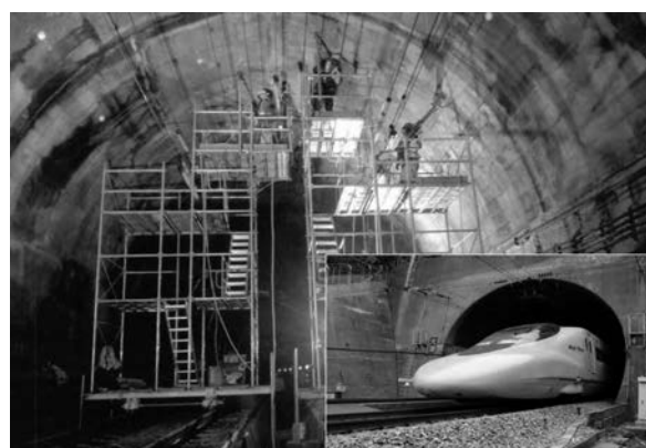
写真－2 新幹線トンネル補修
