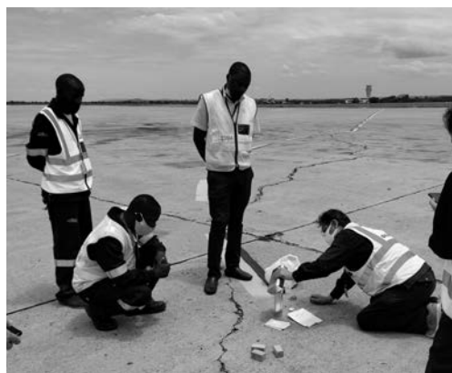
写真－15 ルサカ国際空港駐機場でのひび割れ補修指導
