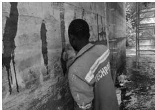
写真－14 橋梁ひび割れの補修状況
