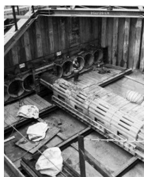
写真－6 引抜型推進機（パイプルーフ工法）
