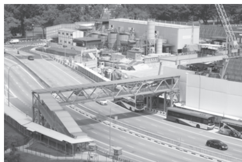
写真－2 泥水処理設備・3 シールドマシン同時掘進立坑状況
