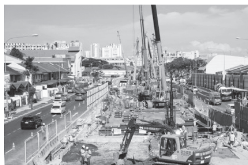
写真－1 幹線道路直下の地下駅 施工状況
