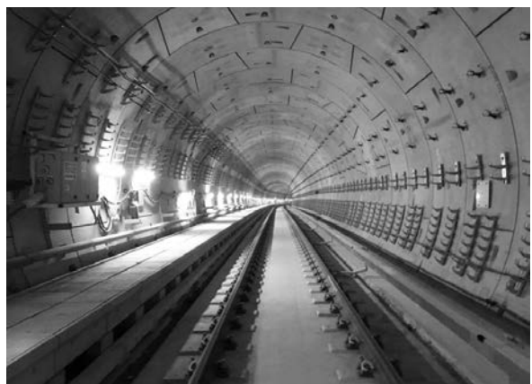
写真－8 トンネル内部
