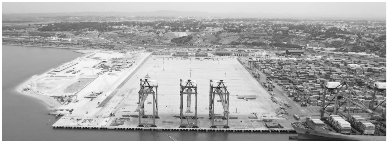
写真－9 工事完成写真（正面：2期工事，右：1期工事）
