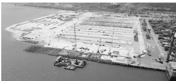
写真－7 コンテナターミナル施工状況全景
