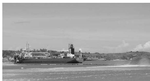
写真-5 TSHD 船による埋立状況
