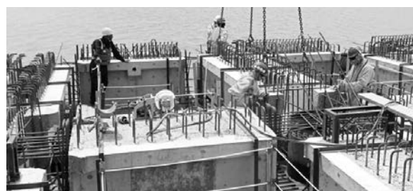
写真-3 棧橋プレキャスト設置状況
