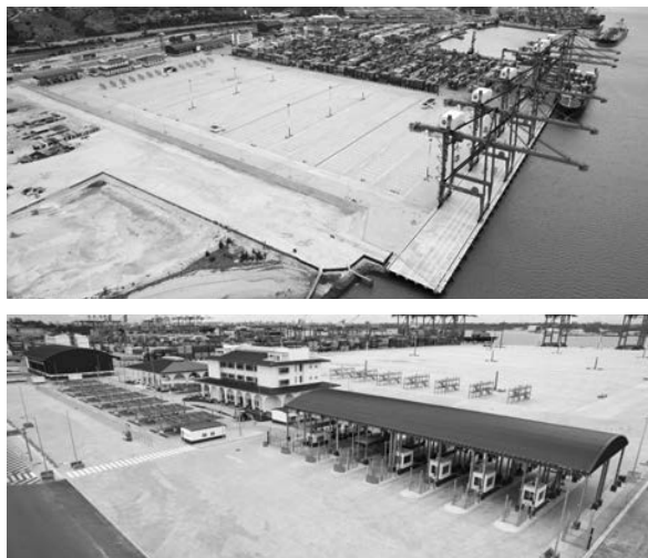
写真－1 工事完成写真
