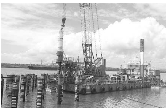
写真一 2 鋼管杭打設状況
