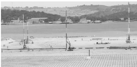
写真－6 PVD 打設状況
