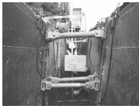
写真－3 簡易土留めパネル使用状況
