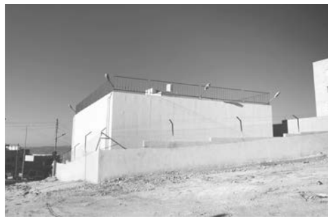
写真－９ 形状変更された配水池 1,100 m 3
