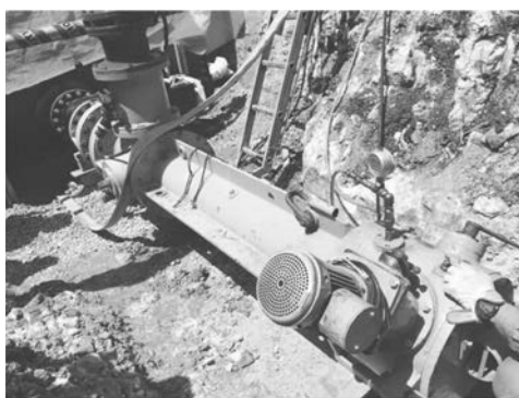
写真－2 不断水施工状況
