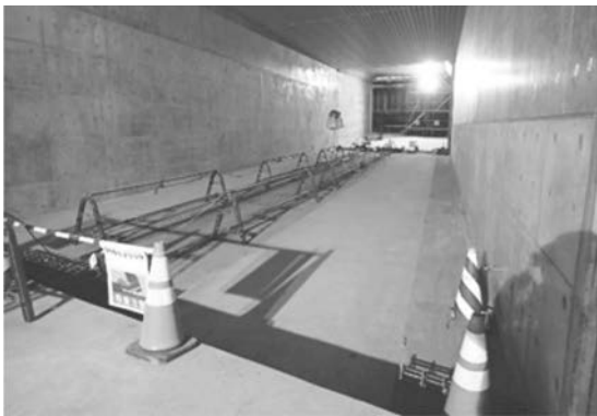
写真-5 構造体表面をコンクリートで被覆した状況
