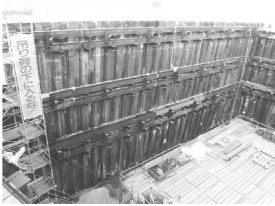
写真-3 JES 函体完成
