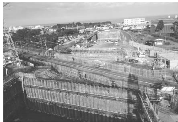
写真-1 発進・到達立坑設置
