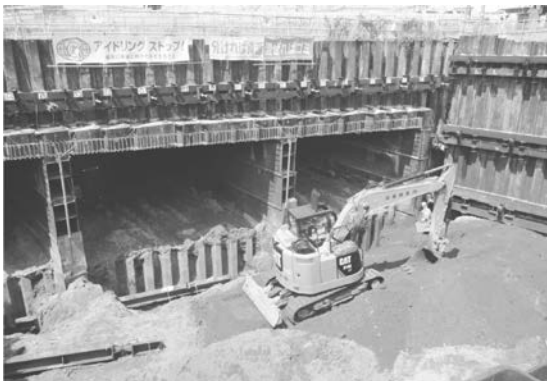
写真-4 構造体内掘削状況
