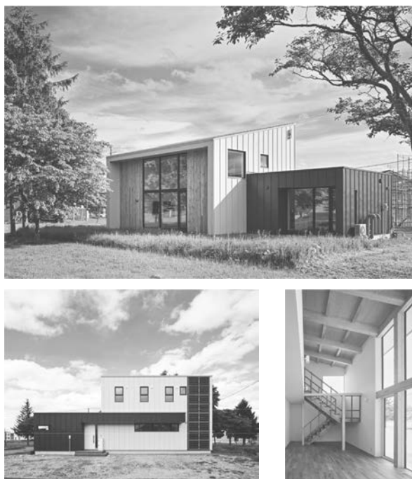
写真-2 南幌町みどり野ゼロカーボンヴィレッジ建設第1号 紺野建設(株)×(株)山本亜耕建築設計事務所
