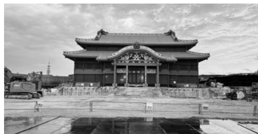
写真－3 外観がおおむね完成した正殿
