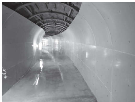
写真－3 導水路 レジンパネル等 仕上げ完了
