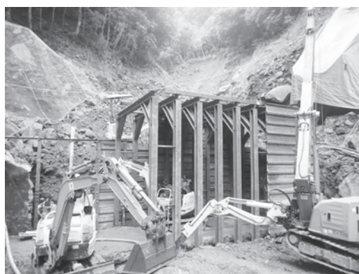
写真－2 導水路 損壊部作業時の鋼製支保工による防護壁
