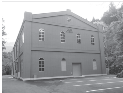
写真－4 白川発電所 新設建屋
