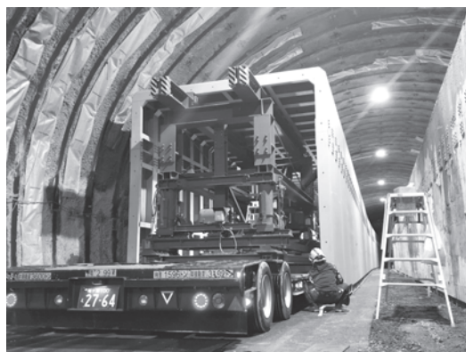
写真-1 プロテクター設置状況（坑内）
