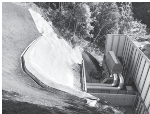
写真-3 集塵機・遮音壁設置状況
