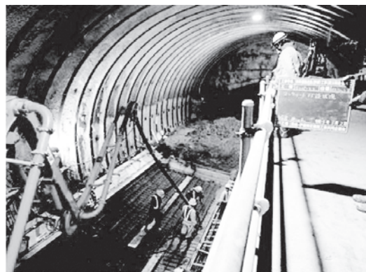
写真-4 貫通前のインバート施工状況
