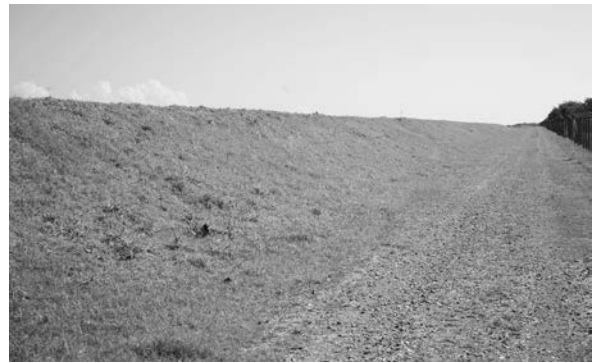
写真－8 空港敷地内に建設した堤防
