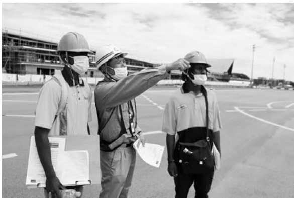
写真-12 大学生を招いた現場研修の様子
