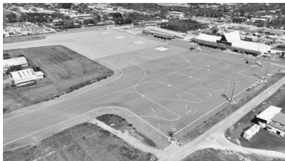
写真-2 拡張後のエプロン
