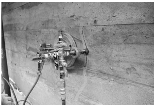
写真-1 圧力調整注入工法による注入施工
