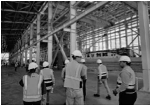
写真-3 第三国研修 パナマ メトロ3号線建設現場
