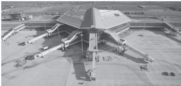
写真－5 円借款で整備されたモンゴル ウランバートル新空港 (出典：オリエンタルコンサルタンツグローバル)
