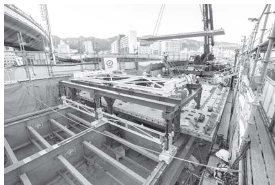
写真－3 床版架設機械と紙製防音装置によるHSPJ床版架設
