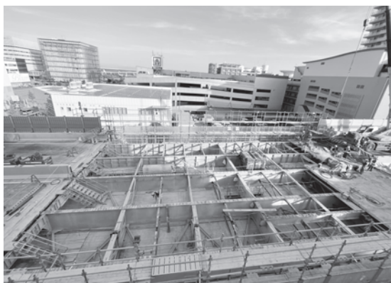
写真－2 既設床版撤去状況
