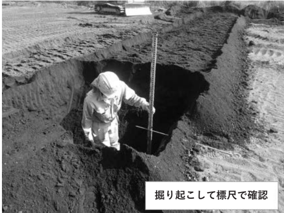
写真-2 掘り起こして施工厚の深度確認
