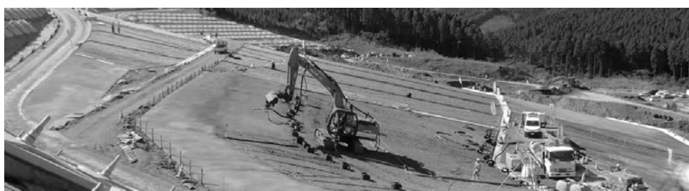
写真－5 施工状況
