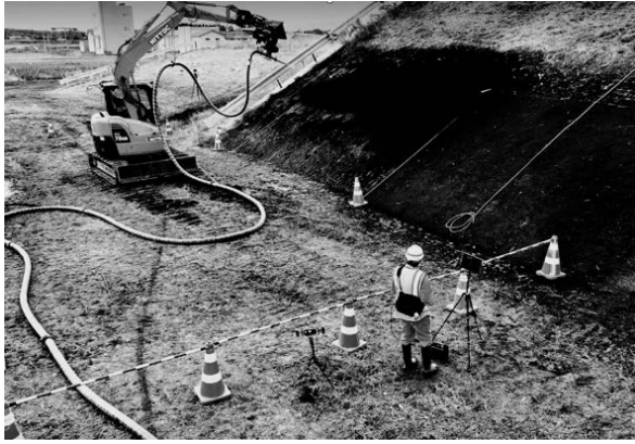
写真-6 実証試験状況
