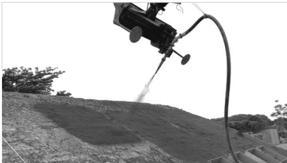
写真－4 植生基材吹付状況
