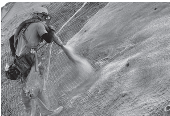
写真-1 モルタル吹付状況
