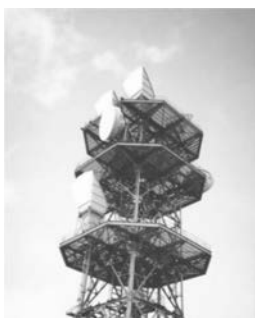
写真-2 NTT無線中継鉄塔
