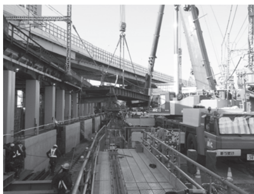
写真－3 工事桁揚重状況
