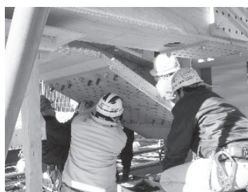
写真－4 木製実寸模型での実施検証の様子
