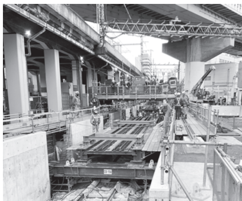
写真－1 B区間の施工状況
