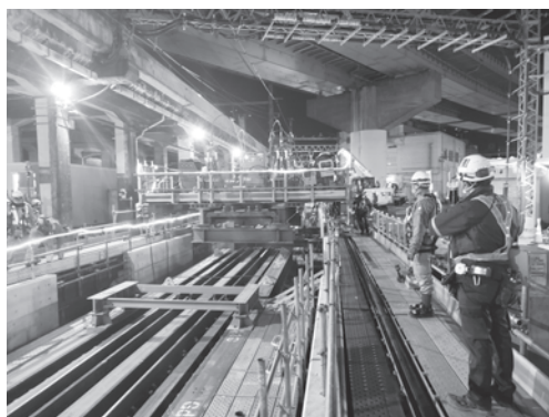
写真－2 搬送台車による縦取状況
