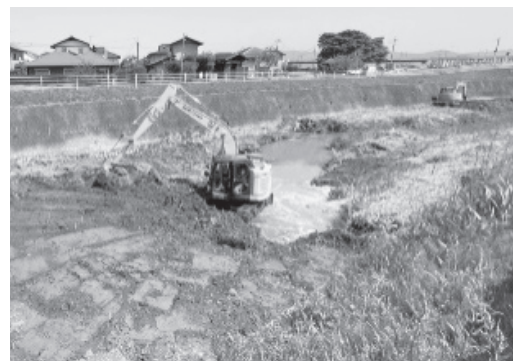
写真-2 河川浚渫状況
