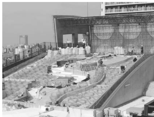
写真－2 メッシュリング施工の様子
