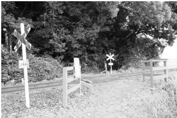
写真－2 北条鉄道・網引駅付近の第4種踏切②
