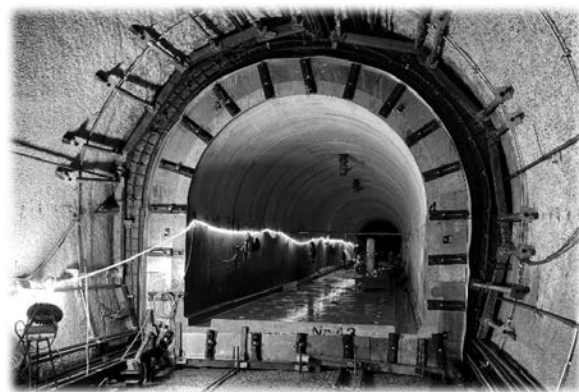
写真－2 妻側エキスパンドメタル・止水版内側ステンレス板
