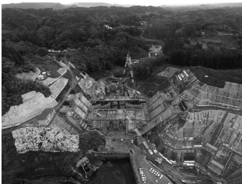
写真－1 打設最盛期の施工状況
