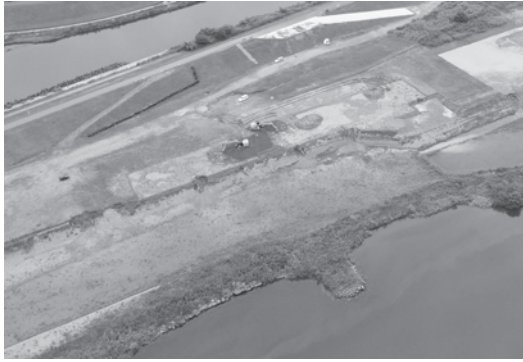
写真-1 ICT 建機による河床掘削状況
