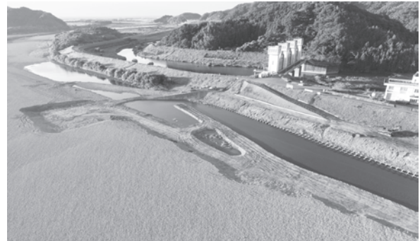
写真-3 無丁張での仮設工事の完了状況
