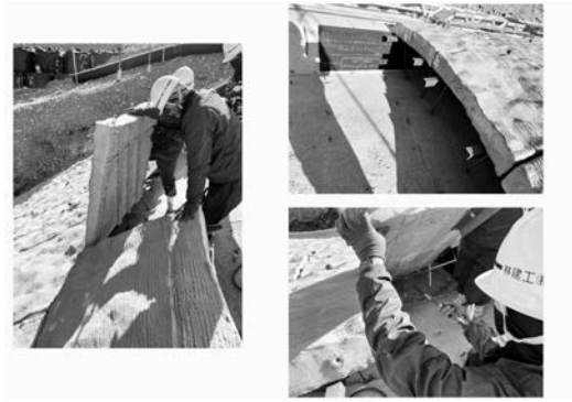
写真-6 建設用3Dパネルの施工状況
