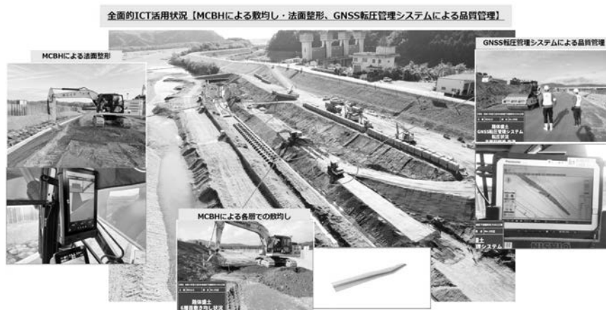
図-1 低水護岸工事での ICT 活用状況
