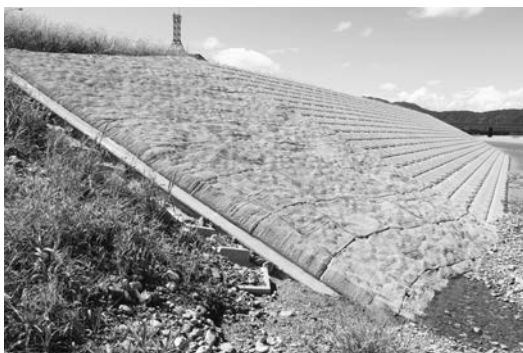
写真-7 擬石型曲線護岸の完成状況
