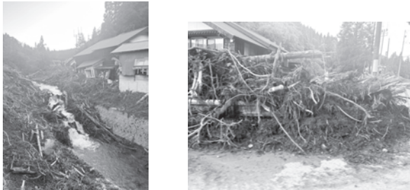
左：9月豪雨による河内川（能登町北河内）の被災 右：河内川沿川家屋
