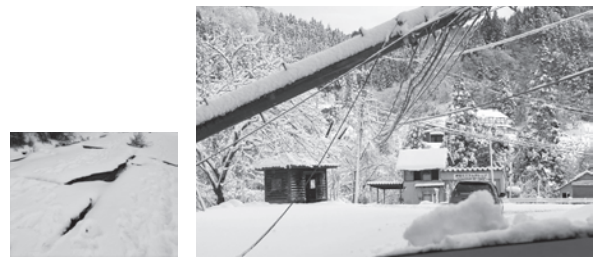
能登町五十里（山間部）電柱倒壊（車中より撮影）
