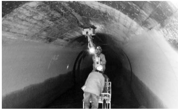
写真-10 管路内における管路背面の地盤の空洞調査例
