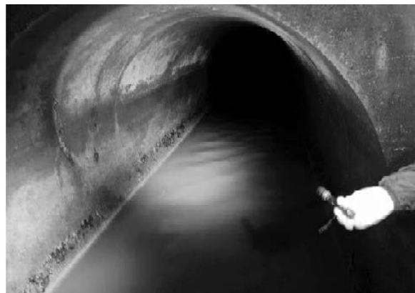
写真-2 下水道管路の緊急点検の様子
