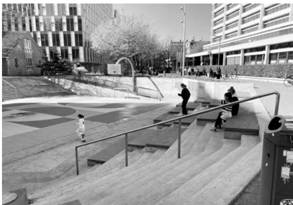
写真－3 都市内雨水調整池（ロッテルダム Rotterdam）（撮影：筆者）
