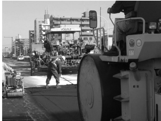
写真 1 舗装現場写真
