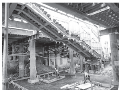
写真－1 既存階段の撤去の様子
