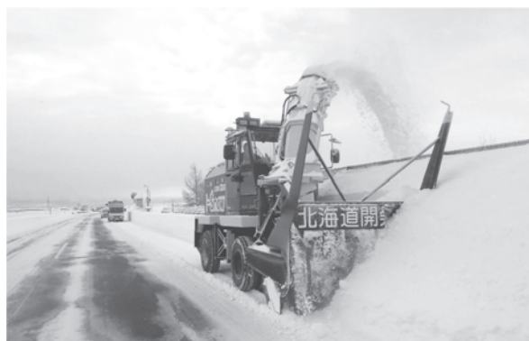
写真-7 ロータリ除雪車の実働状況
