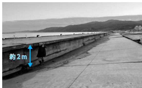
写真-1 被災した港湾施設の例 (輪島港における岸壁背後の沈下)
