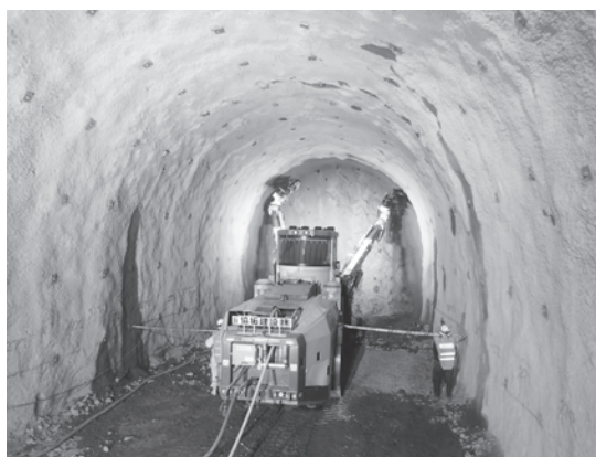
写真－1 穿孔状況（コンピュータジャンボ）
