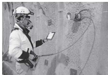
写真－3 省力化ロックボルト引抜試験機
