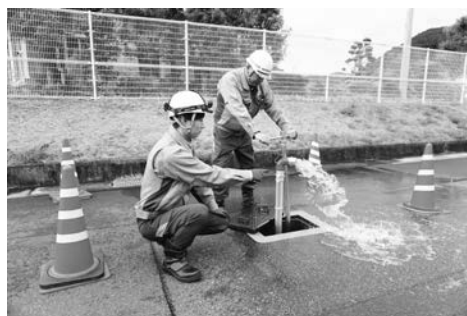
写真－4 ウォーターサービスきほくの水道関連業務（管路保全業務）の様子
