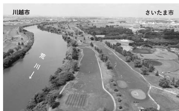
工事着手前（令和3年10月）
