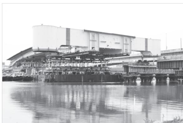
写真－2 台船リフトアップ架設
