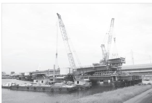
写真－3 トラベラークレーン架設
