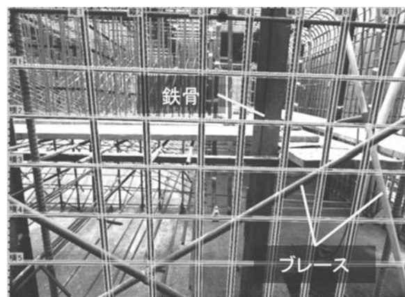
写真-3 鉄骨やブレース除去状況
