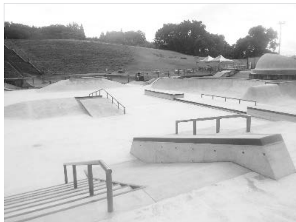
写真－16 完成したストリートコース
