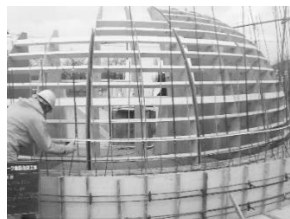
写真-11 櫛型枠設置状況
