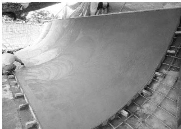
写真-8 最終仕上げ直後の滑走面の状況
