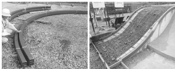
写真－14 コーピング(特 殊曲げ加工)
