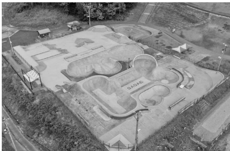
スケートパーク全景（改修後）
