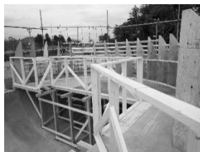
写真-12 足場支保工設置状況
