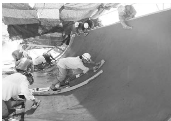
写真-7 二次仕上げ状況
