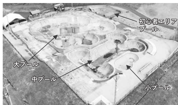
写真－1 スケートパーク全景（改修前）
