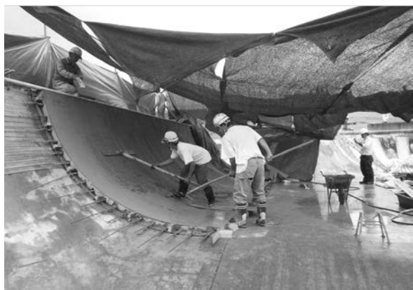
写真-6 粗仕上げ状況
