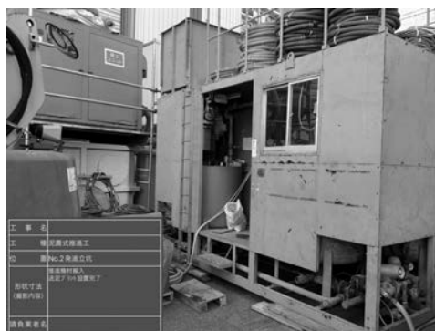
写真-3 泥濃推進工(送・排泥設備工)の施工状況
