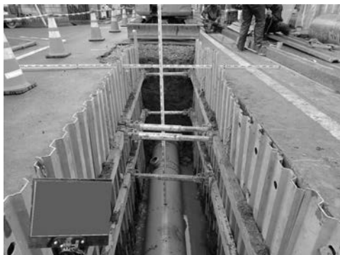
写真-2 管布設工の施工状況
