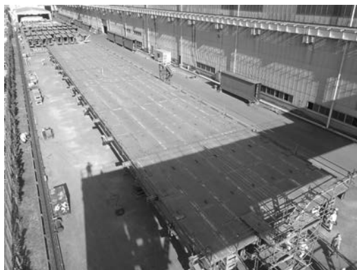
鋼床版鈹桁①
