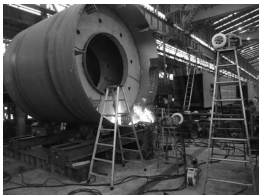
丸型鋼橋脚②
