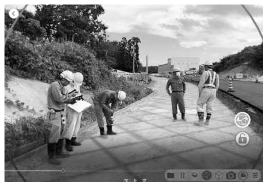
写真-1 AR技術を用いた出来形管理の事例
