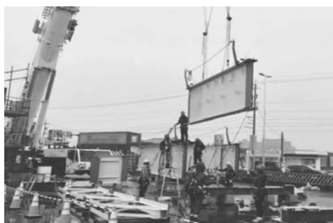
写真－39 地組工作業状況
