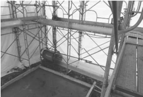
写真－22 養生状況
