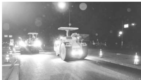
写真－11 ロードローラ・タイヤローラによる締固め
