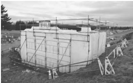
写真－21 仮囲い設置状況（Wタイプ）
