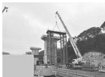
写真－41 ベント設備設置作業状況
