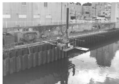
写真-34 水上施工状況
