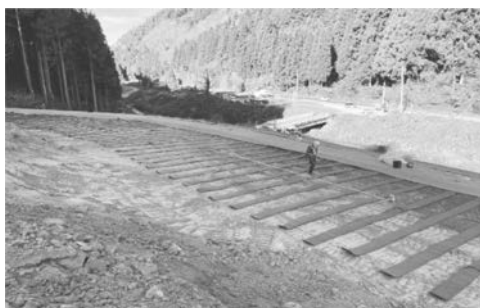
写真－３ 水平排水材設置作業終了後全景
