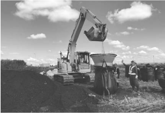
写真－23 大型土のう製作状況
