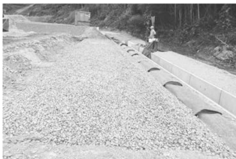
写真－４ フィルター層敷設作業終了後全景
