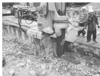
写真-36 引抜作業状況
