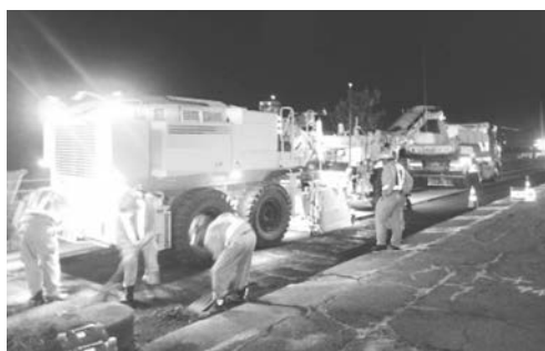
写真-8 路面切削機（ICT）による切削作業
