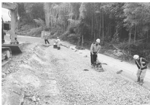
写真－２ フィルター層敷設作業状況
