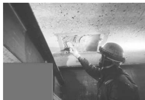
写真－27 断面修復（左官工法）作業状況
