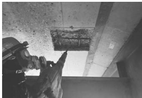
写真－26 コンクリートはつり作業状況
