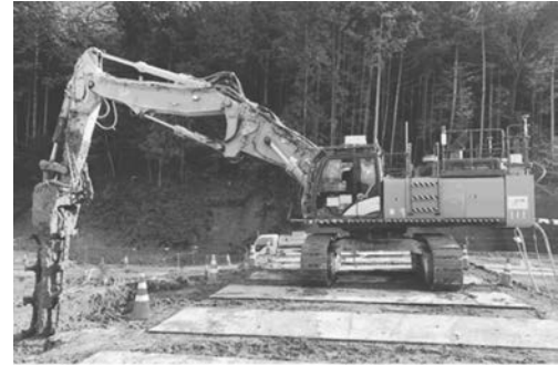
写真－５ 地盤改良作業状況
