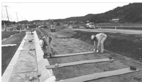
写真－１ 水平排水材設置作業状況
