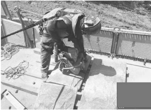
写真－16 残存型枠加工状況
