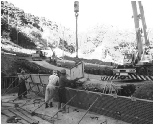
写真－17 型枠設置作業状況
