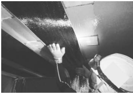
写真－ 37 炭素繊維シート貼付作業状況
