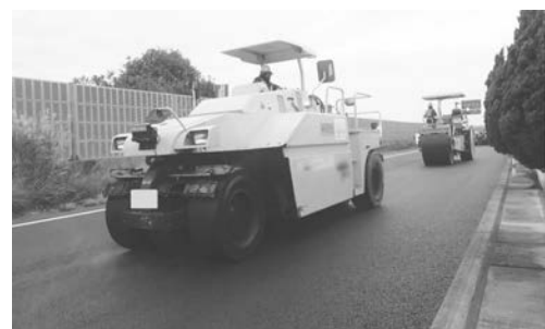
写真－31 ロードローラ・タイヤローラによる締固め
