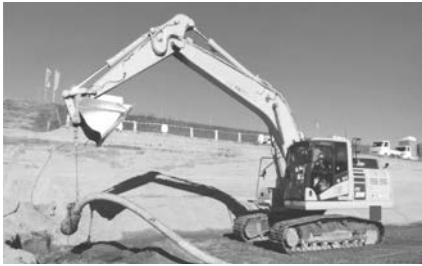
写真－18 ポンプ設置作業状況
