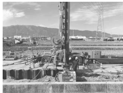
写真-33 ウォータージェット併用圧入作業状況
