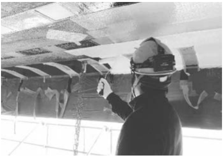
写真－ 38 仕上げ塗装作業状況
