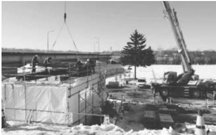
写真－20 仮囲い施工状況（Wタイプ）
