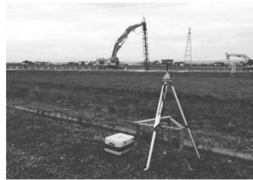
写真－６ ICT 基地局と施工機械全景
