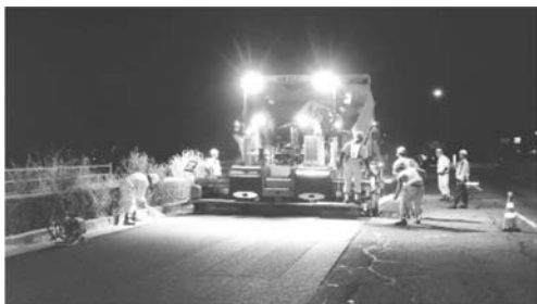
写真－10 アスファルトフィニッシャーによる敷均し
