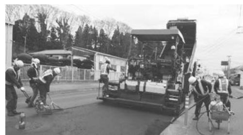
写真－30 アスファルトフィニッシャーによる敷均し
