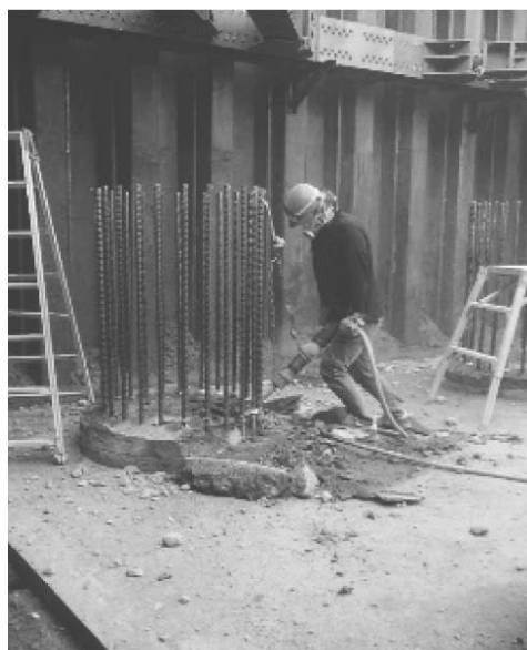
写真－15 杭頭処理作業状況
