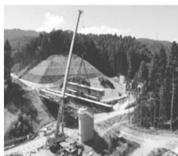
写真－40 主桁架設作業状況
