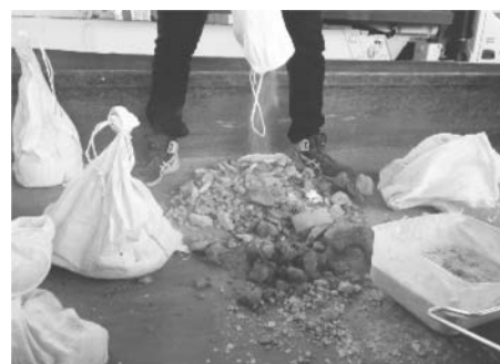
写真－28 コンクリート殻積込施工状況
