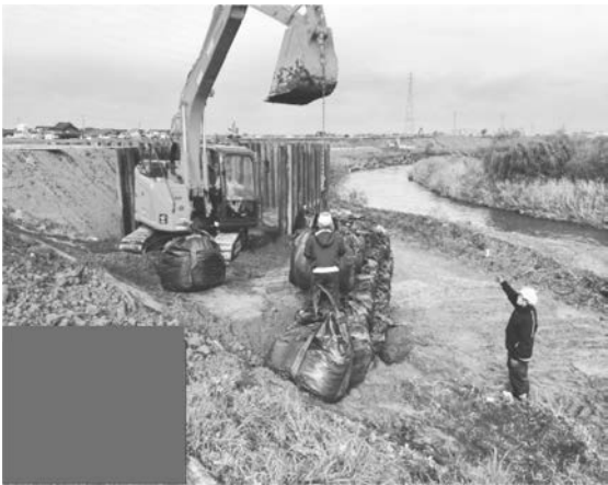
写真－24 大型土のう設置状況
