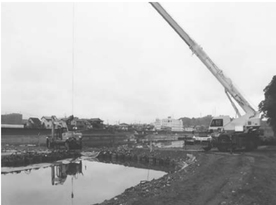
写真－25 大型土のう移設状況
