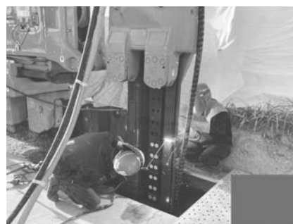
写真-35 鋼矢板継ぎ作業状況
