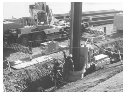
写真-32 単独圧入作業状況
