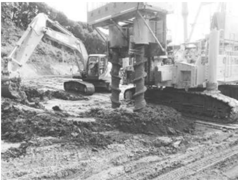
写真－13 二軸施工 (変位低減型)
