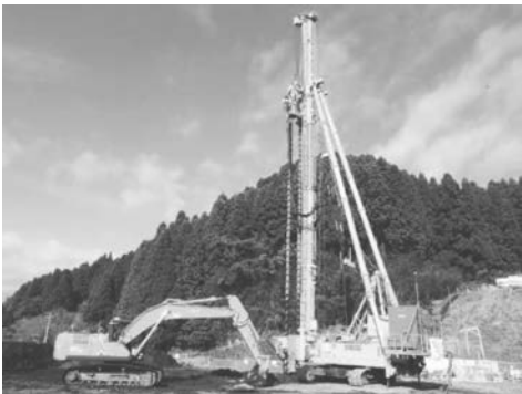
写真－12 二軸施工
