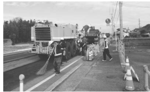
写真－29 路面切削機による切削作業
