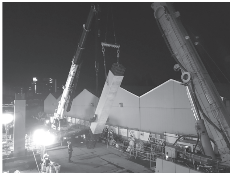
写真－1 プレキャスト柱の建て起こし状況
