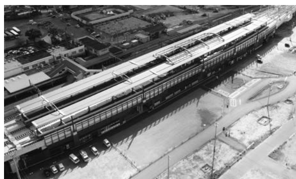
写真－1 JR 松山駅西口付近
