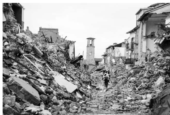
写真－1 イタリア中部地震の被災状況
