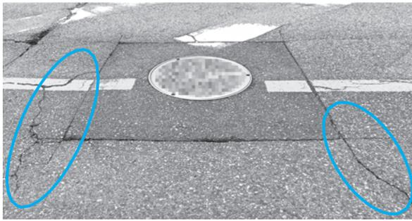
図-1 雨水等の浸入による舗装の損傷・沈下
