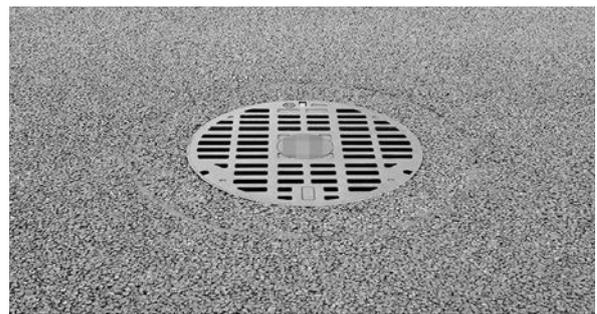
写真-5 ERアスコン（排水用）で舗装復旧
