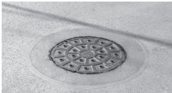
写真-4 ERアスコン（密粒用）で舗装復旧
