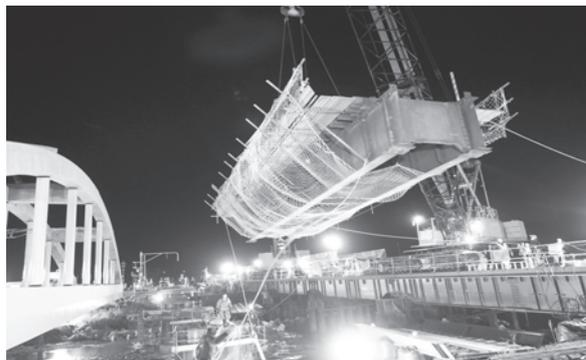
写真－4 200t クローラークレーンによる現橋梁の撤去
