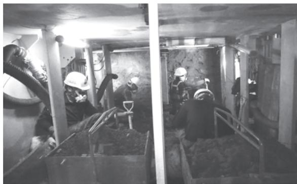
写真－2 鋼製箱型 Box（JES エレメント）挿入の人力掘削
