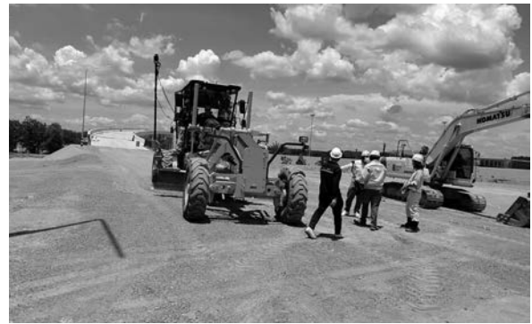
写真－3 三次元マシンコントロールによる整地作業の様子
