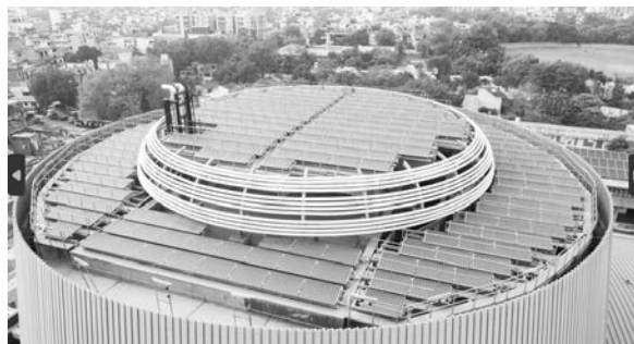
写真-8 タワー上部に設置した太陽光パネル
