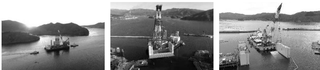
写真-2 現地据付状況 3) (左：本体二次曳航，中：本体据付，右：扉体現地据付)
