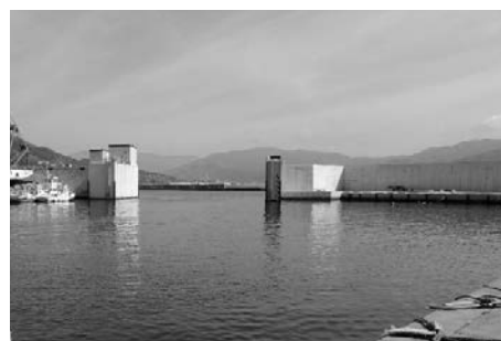
写真-3 港内から見たフラップゲート式可動防波堤初号機 1)
